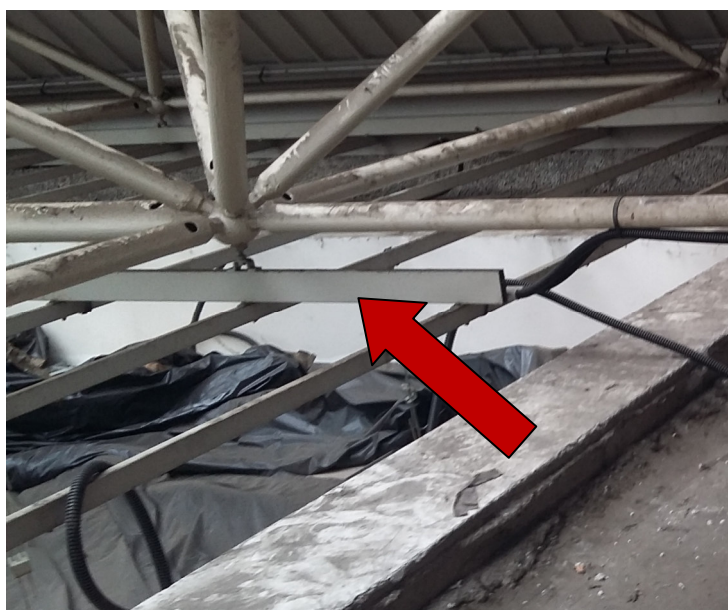
Figura 12 - Carpenteria metallica oggetto di modifica e cerchiatura
