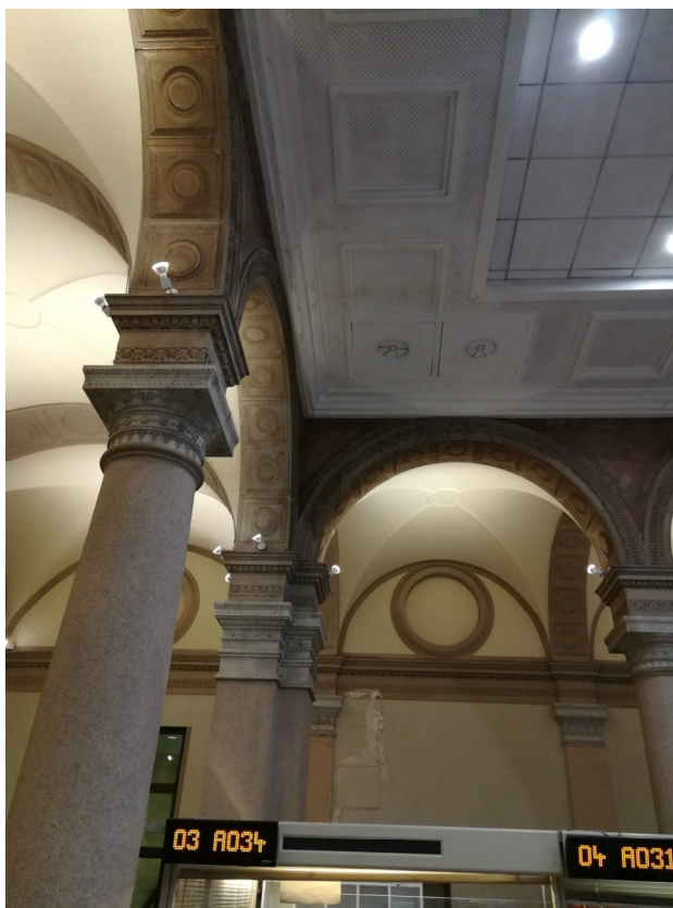
Figura 14 - Dettaglio di porzioni di intonaco ammalorate
